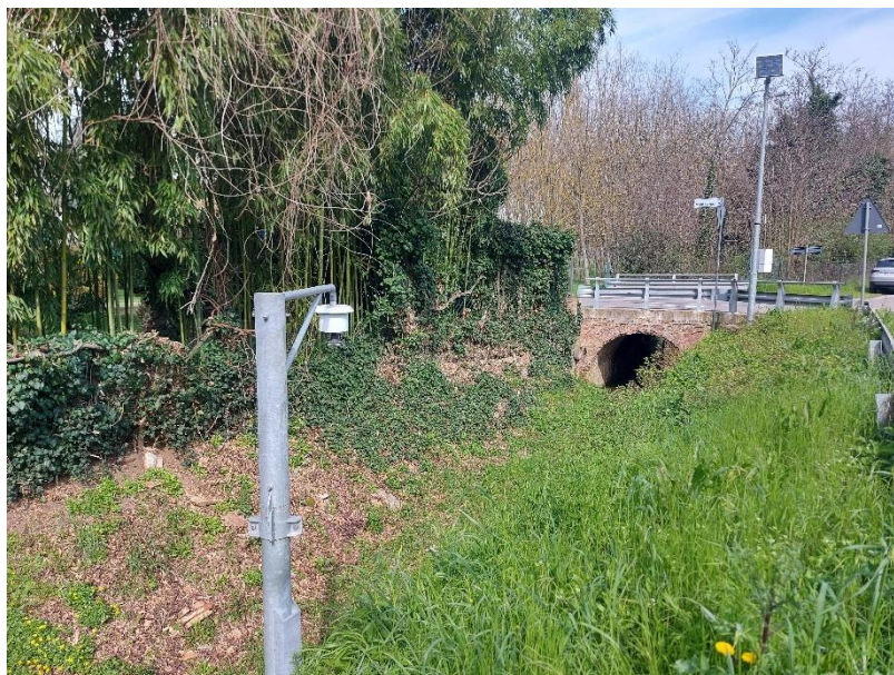
Figura 33: fotografia 3 – Vista del ponte all'incrocio tra Via Montevercchio e Via L. Da Vinci dal bordo stradale di Via L. Da Vinci, nella foto sono si vedono l'attuale pannello solare ed il misuratore di livello dei quali è previsto lo spostamento
